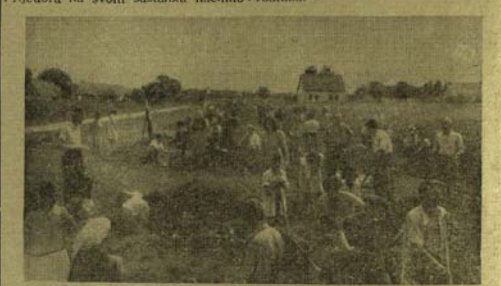
Gradnja Prijedora dobrovoljnim radom pomoću gradnih radničkih stanova
