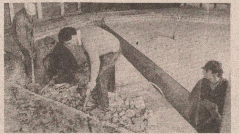
Radovi na rekonstrukciji unutrašnjeg prostora
