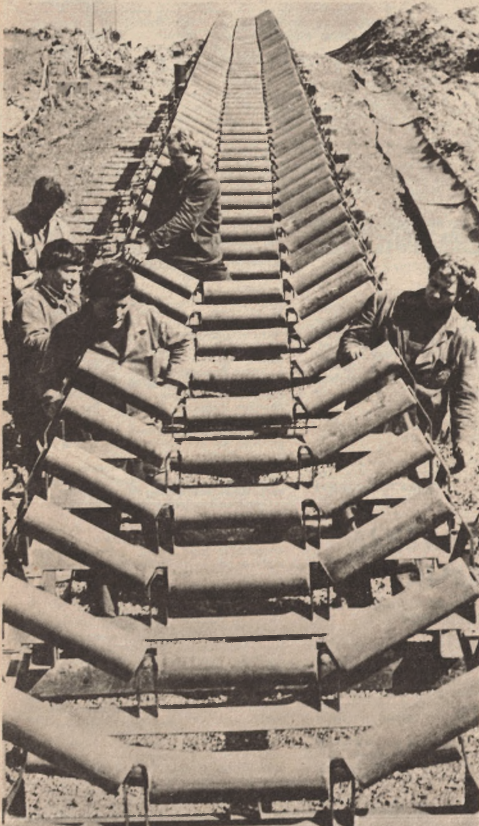
Montažeri iz Tuzle rade na postavljanju pokretnih traka, koje će moći da „vade“ rudu i pri nagibu od 18 stepeni, dok kamioni demperi ne mogu da voze,
