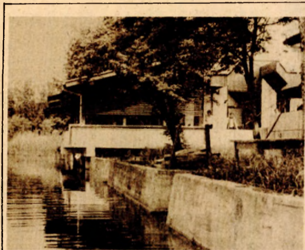
Pogled sa vode. Terasa motela nalazi se nad samom površinom jezera što je poseban ugođaj za goste
