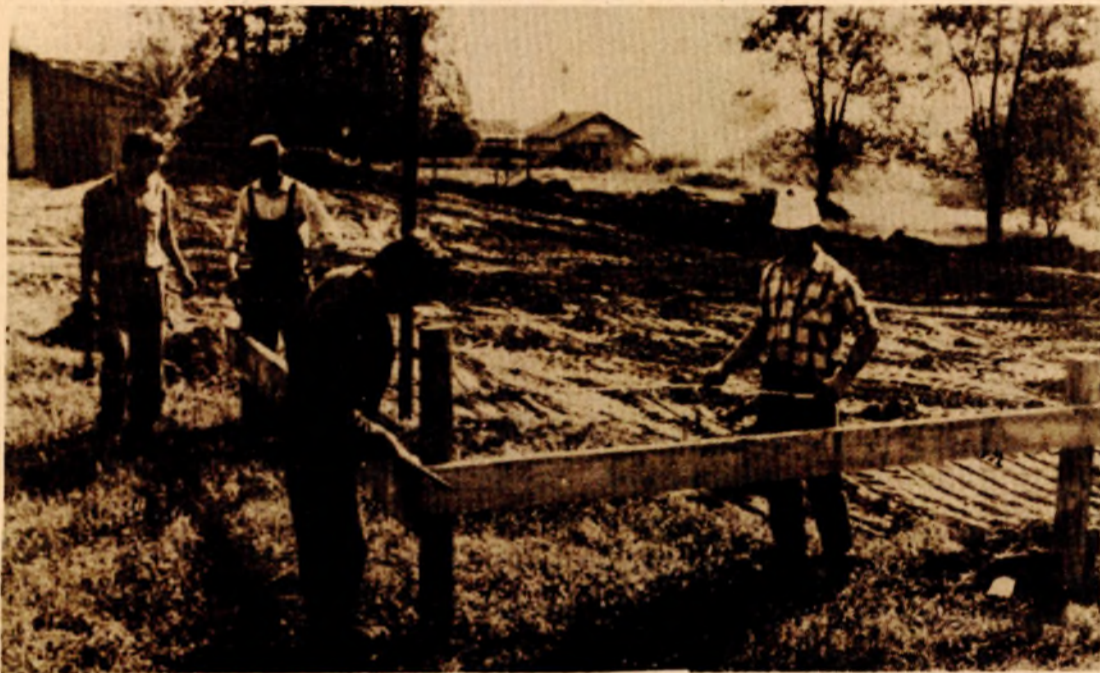
Na gradilištu stambeno-poslovne zgrade tek su počeli radovi, ali će posao biti završen na vrijeme
