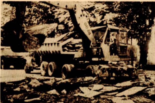
Početak radova druge faze sanacije Ulice Mladena Stojanovića
