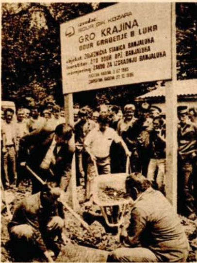
Polaganje kamena temeljca: Stevo Vučković
