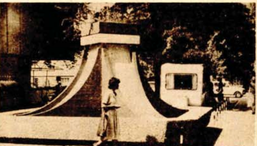
Ispred Robne kuće „Centar“ fontana je zarasla u travu i korov
