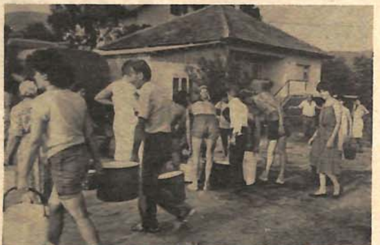
Kad cisterna stigne, ostavljaju se i najpreči poslovi
