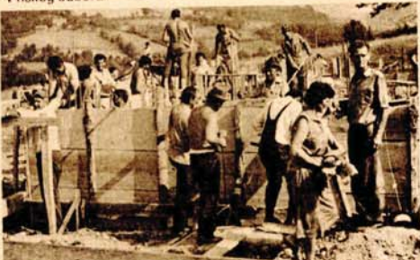
Sa gradilišta budućeg doma
