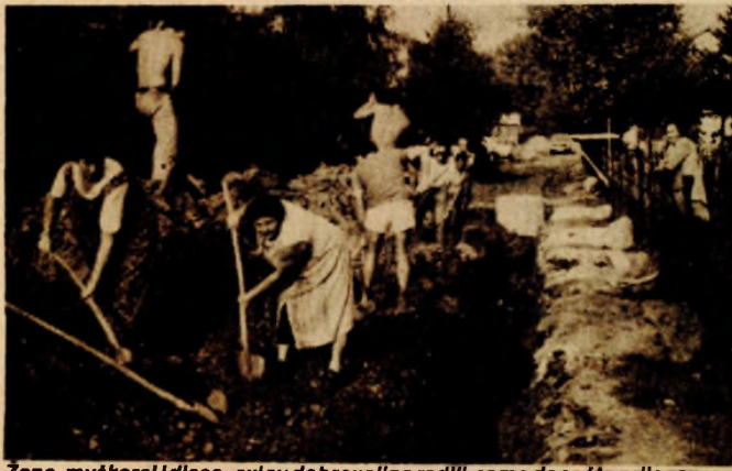
Zene, muškarci i djeca - svi su dobrovoljno radili, samo da se što prije završi izgradnja kanalizacije
