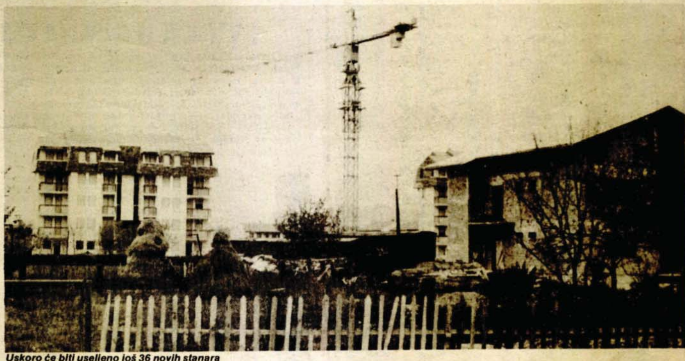
Uskoro će biti useljeno još 36 novih stanara
