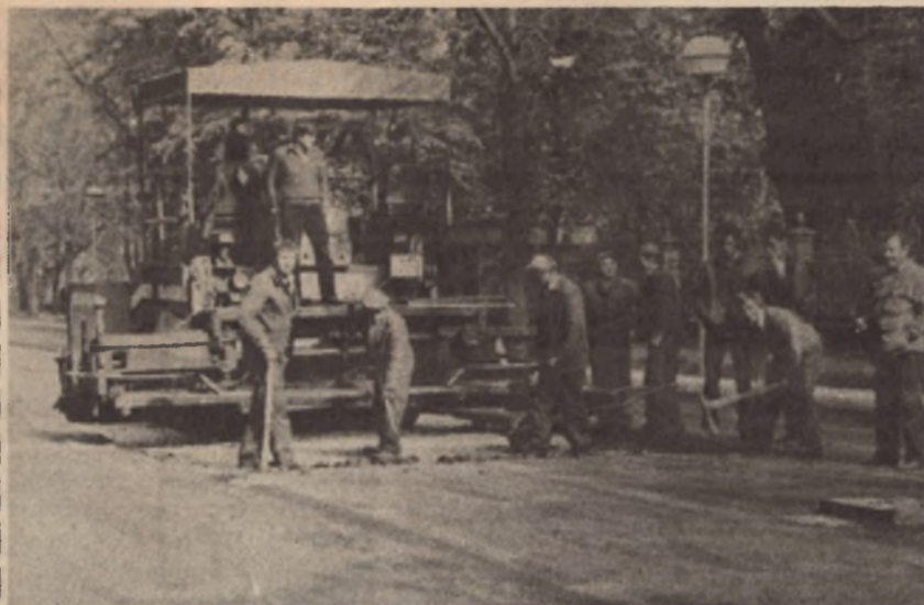
Prvi metri asfalta položeni su u petak
