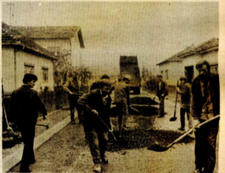
Asfaltiranje ulica u Srpcu
