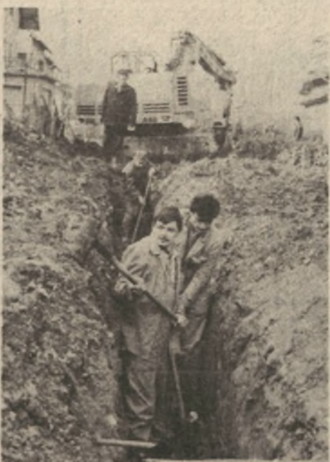
Lijepo dane radnici „Hidromontaža“ koristili su da što prije završe posao, ali tvrde da ih neće omesti ni prvi snijeg
