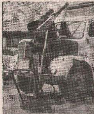
JEDNOSTUBNA PNEUMATSKA AUTO-DIZALICA DAI, NOSIVOST 15-25 kN
