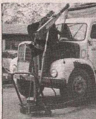
JEDNOSTUBNA PNEUMATSKA AUTO— DIZALICA DA1, NOSIVOST 15-25 kN
