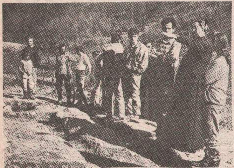
Освећење темеља и постављање крста 8. маја
