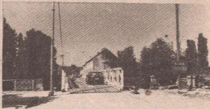
Мост на Петрињци
