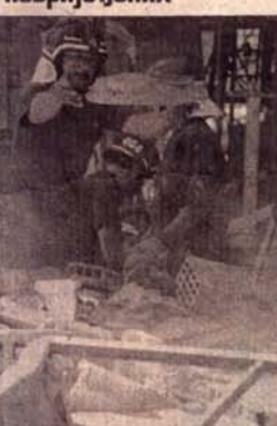
Ватрогасци раширишћавају рушевине на мјесту експлозије
