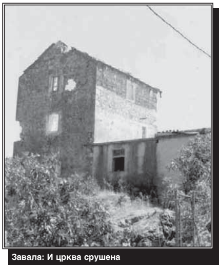
Завала: И црква срушена
