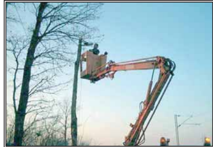
Електричари: Постављају уличну расвјету
