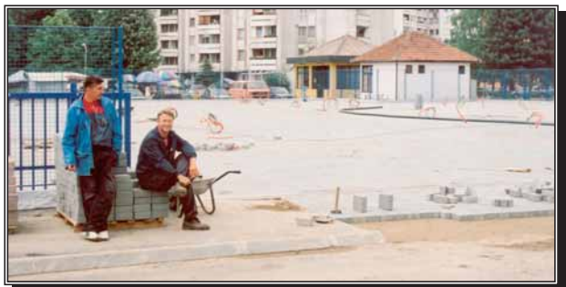
Борик: Постављена ограда, бетонска галантерија, асфалтиран паркинг (СНИМИО 3. СТАМЕЊИЋ)
