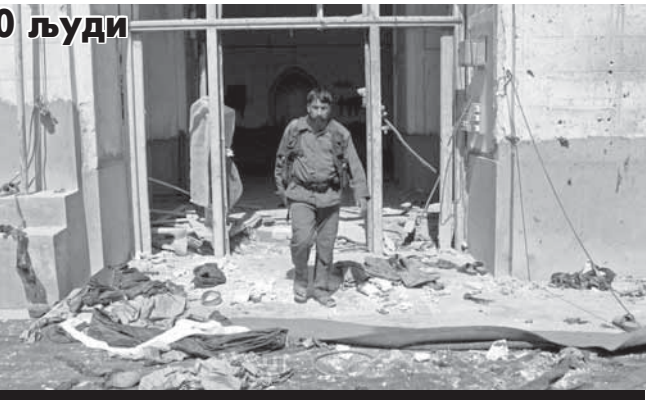
Кабул: Оштећена цамија (Фото-Ројтерс)
