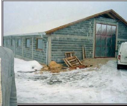
Изградња: Нова фарма Марка Томића
