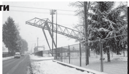
Демонтажа крана: Опасност и за објекте и за саобраћај
