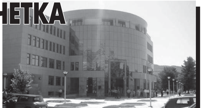
Електропривреда Републике Српске: Нови поступак
