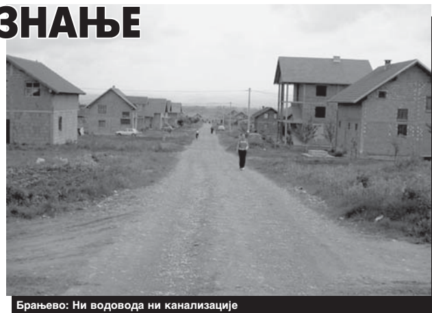
Брањево: Ни водовода ни канализације
