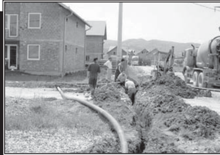
Радови у насељу: Изградња седам километара водовода
