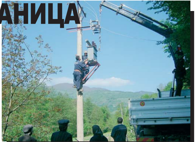
Доње Оћуне: Електромонтери обављају завршне радове
