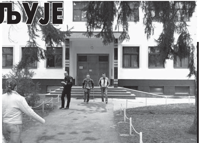
Зграда општине у Теслићу: Проширују администрацију
