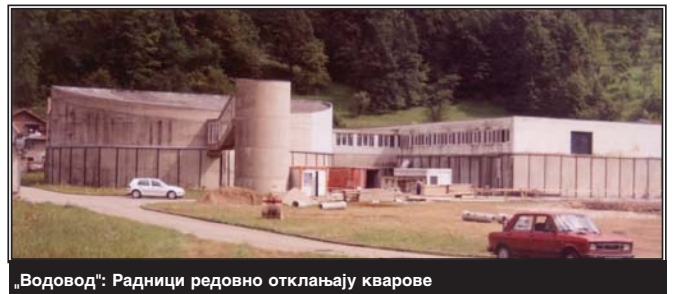
„Водовод“: Радници редовно отклањају кварове
