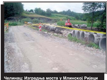
Челинац: Изградња моста у Млинској Ријеци
