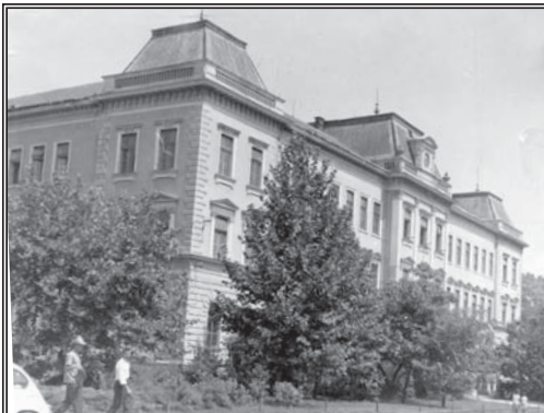
Тузланска Гимназија срушена шездесетих година прошлог века због слегања терена
