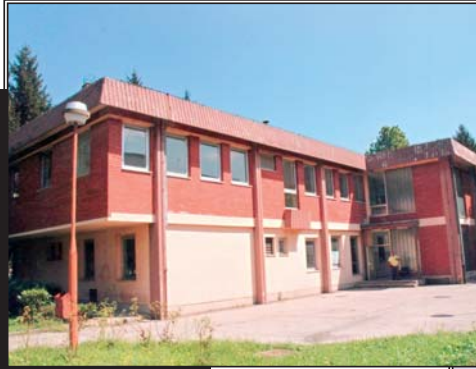
Будућа зграда Службе хитне помоћи: Бољи услови за рад
