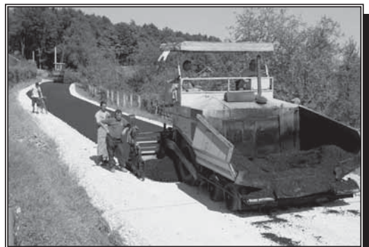
Вршани: Радници и механизација предузећа „МГ Минд“ полагају асфалт
