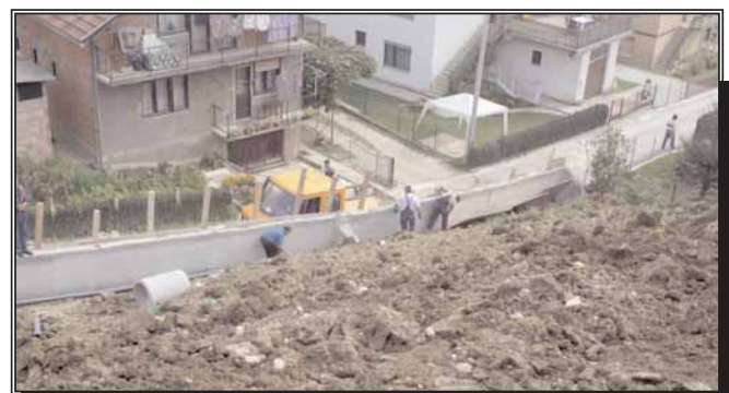
Клизиште: Изградња потпорних зидова (Снимко Р. ШИВАРЕВИЋ)
