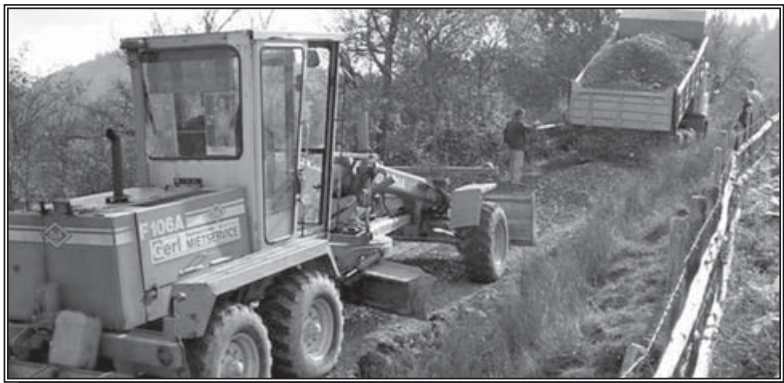
Земљани радови: Уређење пута Кадића брдо - Жуљ
