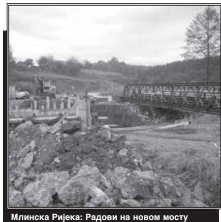
Млинска Ријека: Радови на новом мосту
