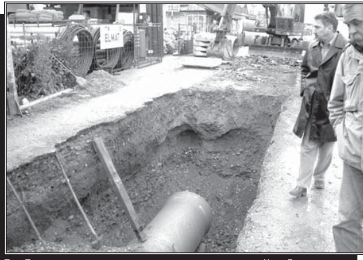
Трн: Почела изградња главне канализационе мреже у улици Цара Душана
