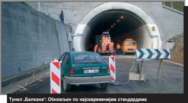
Тунел „Балкана“: Обновљен по најсавременијим стандардима
