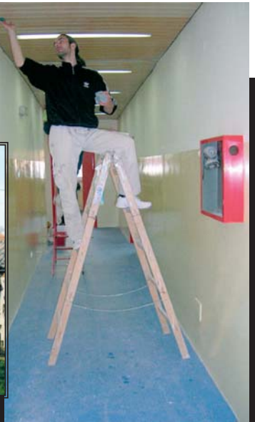
Нове просторије Службе хитне помоћи: Завршно уређење
