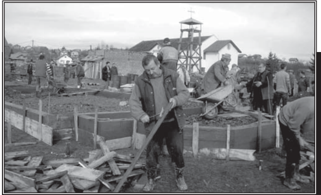
Градња темеља: Хоће ли инспекција обуставити радове?
