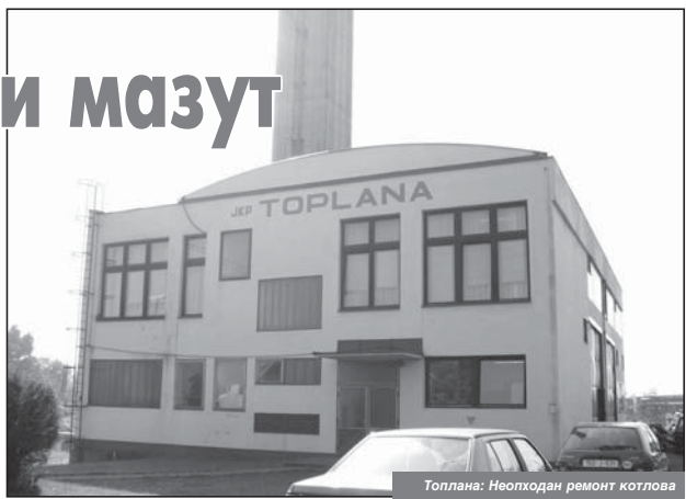
Топлана: Неопходан ремонт котлова
