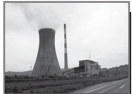
Термоелектрана „Угљевик 1“: Пуни општински буџет
