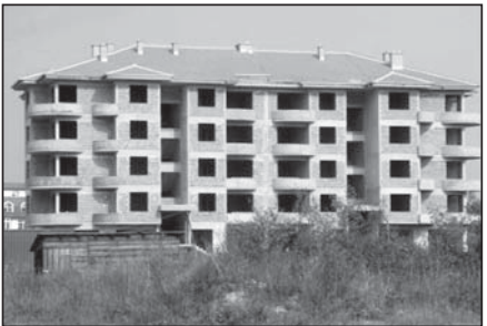
Нова борачка зграда у Пњавору: На реду унутрашње уређење
