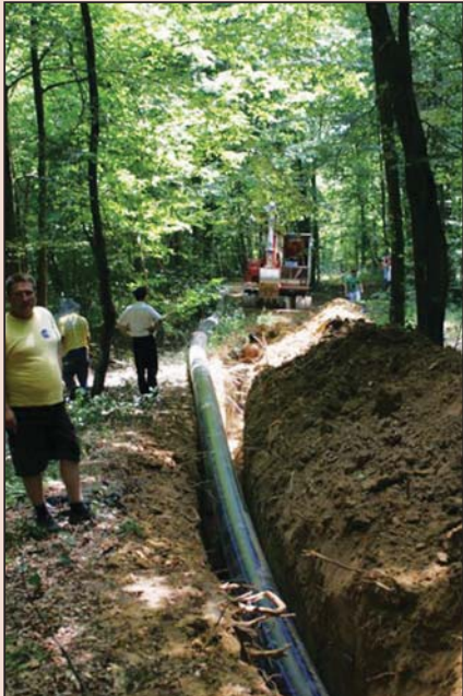
Настављени радови: Копање и постављање главног потисног вода у Повеличу
