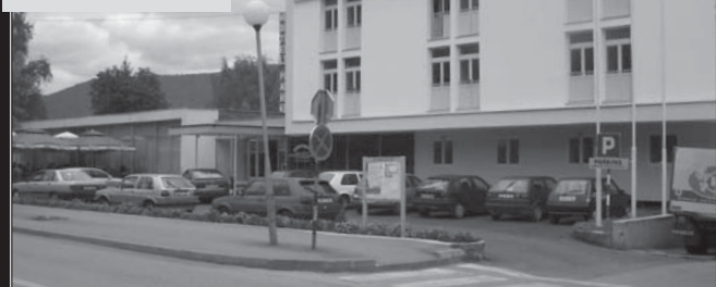
Хотел „Парк“: Стављена нова фасада
