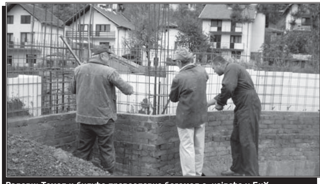
Радови: Темељи будуће православне богомоље, највеће у БиХ
