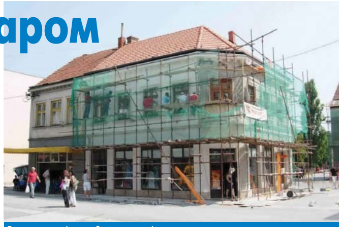
Радови у главној улици: Зградама нове фасаде
