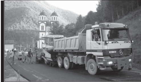
Околина цркве: Асфалтирање прилазног пута
